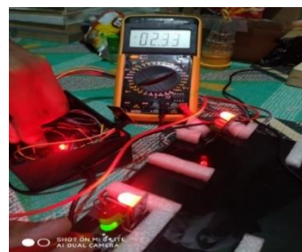
Gambar 13. Pengukuran Tegangan pada LED (Sumber : dokumen pribadi)
