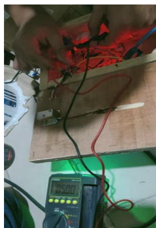
Gambar 6. Pengukuran Tegangan Relay
